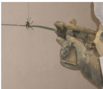
Inyección a través de pequeños taladros
