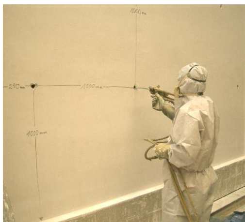
Inyección de poliuretano para mejorar la eficiencia energética de la fachada
