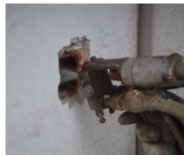
Inyección a través de aberturas mayores
