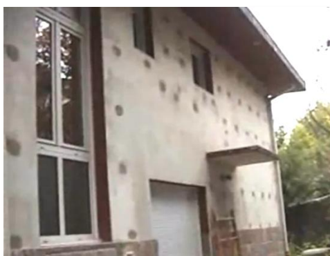
Estado de la vivienda tras mejorar la eficiencia energética, a la espera del acabado final
