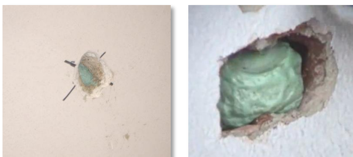
Orificios de inyección rellenos, antes del sellado
